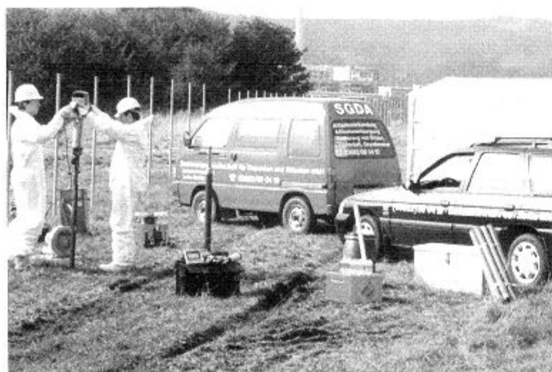
Mitarbeiter der SGDA Sanierungsgesellschaft für Deponien und Altlasten mbH bei der Altlastenerkundung vor Ort
