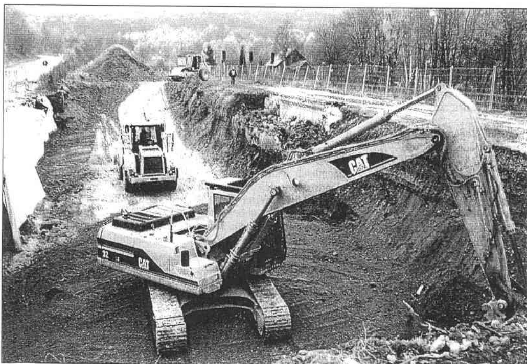
Bis in sieben Meter Tiefe musste das belastete Erdreich an der ehemaligen Abtankstation an der Schönen Aussicht abgetragen und ausgetauscht werden. FOTO: KARL-HEINZ FRANK
