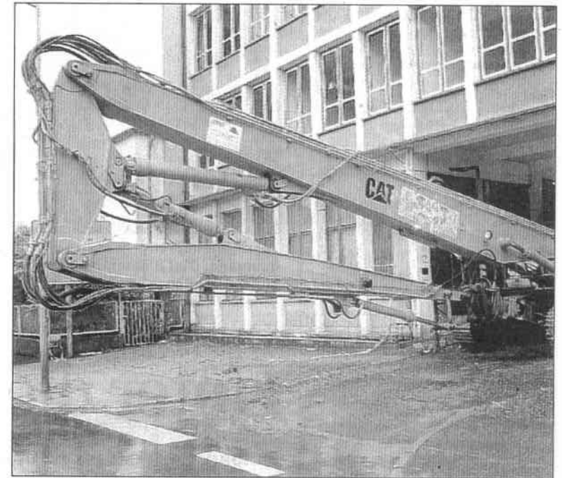
Mitarbeiter der SGDA aus Zella-Mehlis haben mittlerweile ihre Arbeiten zur Entkernung der Hydraulik-Ruine aufgenommen. —FOTO: MARIO HÖSEL
