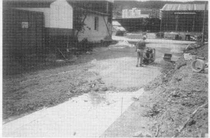
3: Einbau des immobilisierten Gutes als Tragschicht
