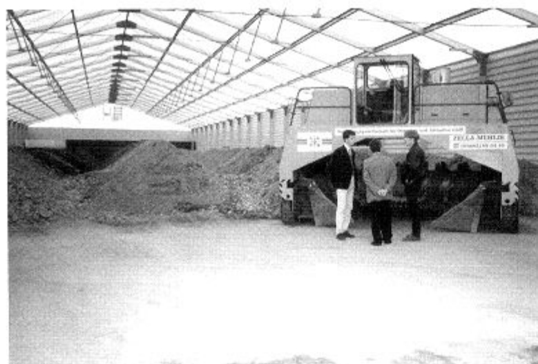
Sanierung der Barbara Kaserne in Meiningen per On-site-Technologie
